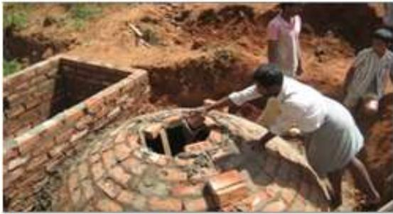
Photographie 14-a : Construction d'un réservoir à biogaz en Inde. Valorisation des déchets animaux pour la production d'énergie.
